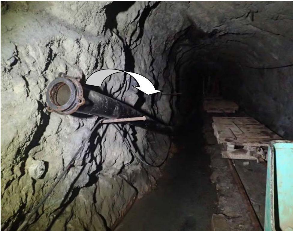
アンカーで固定されていた配管
