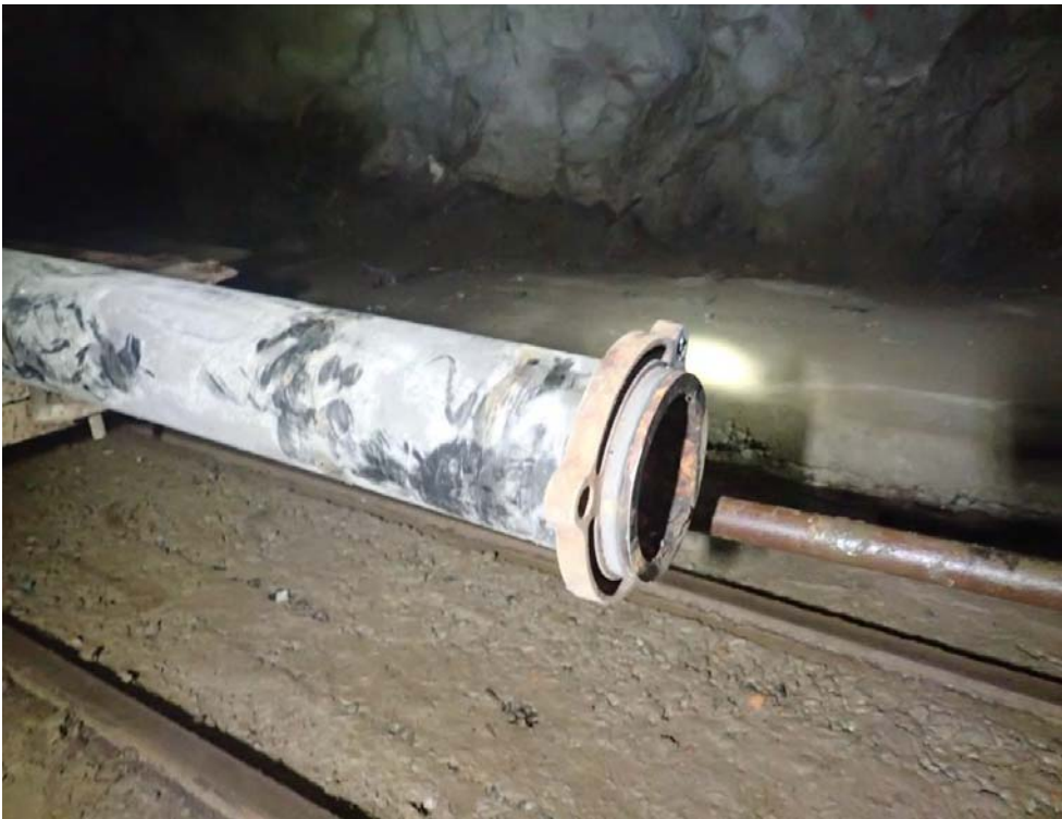
落下したポリエチレン管と鉄製接続金具
