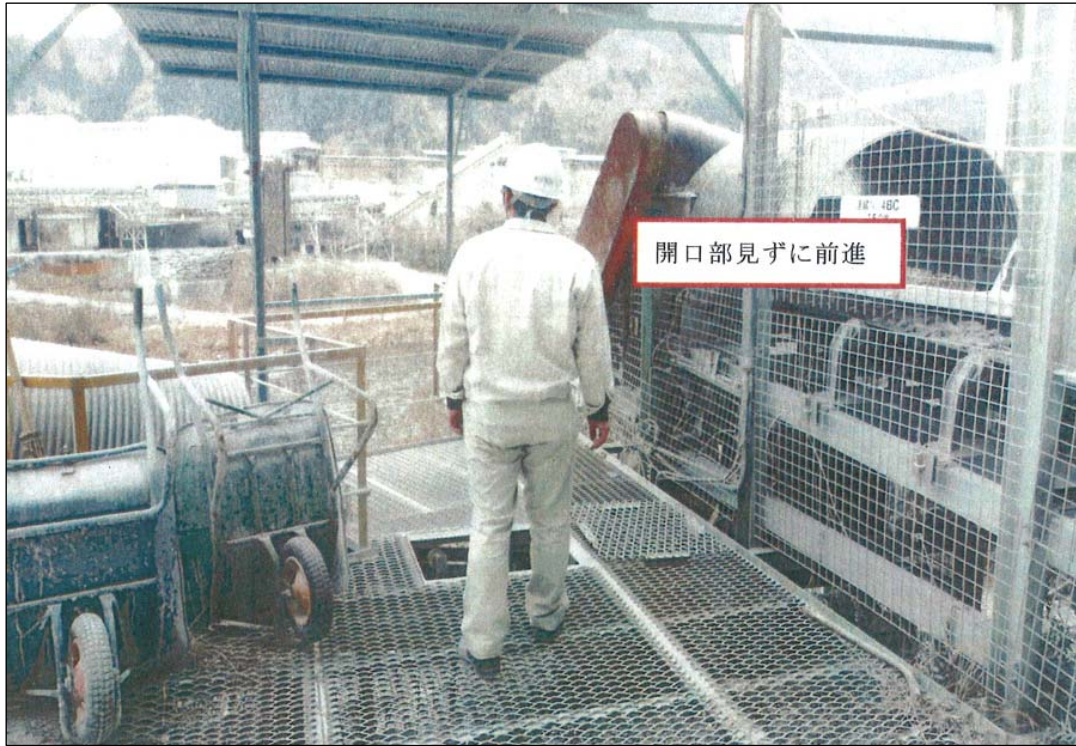
罹災状況①
