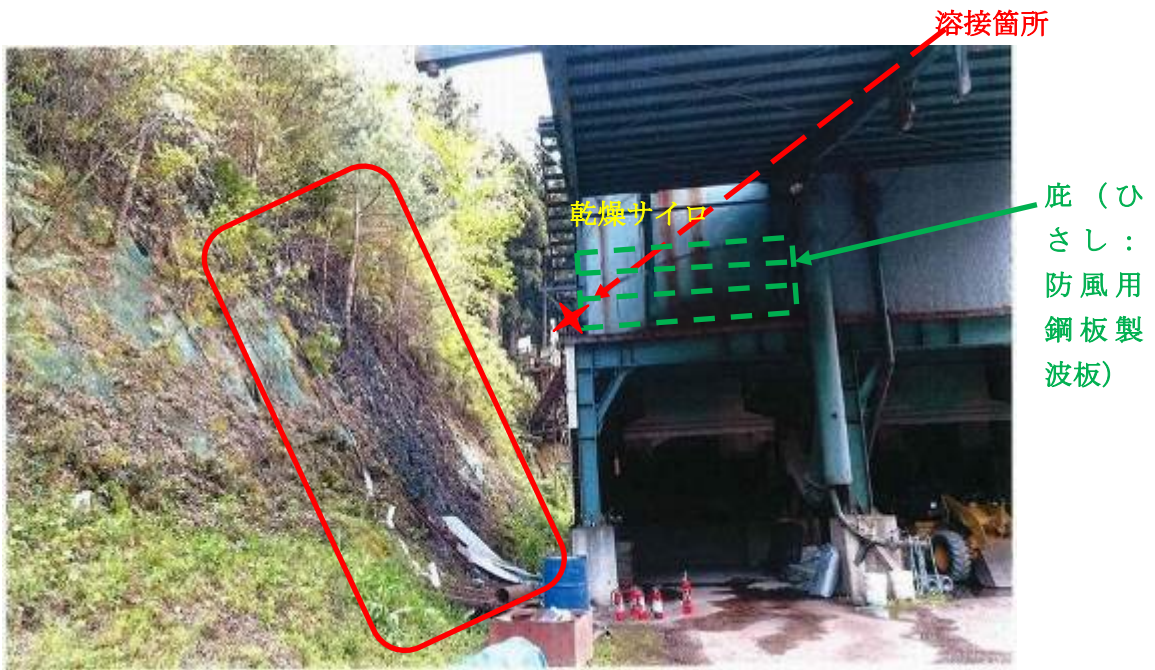
写真1 災害発生箇所の状況 (□が延焼箇所)
