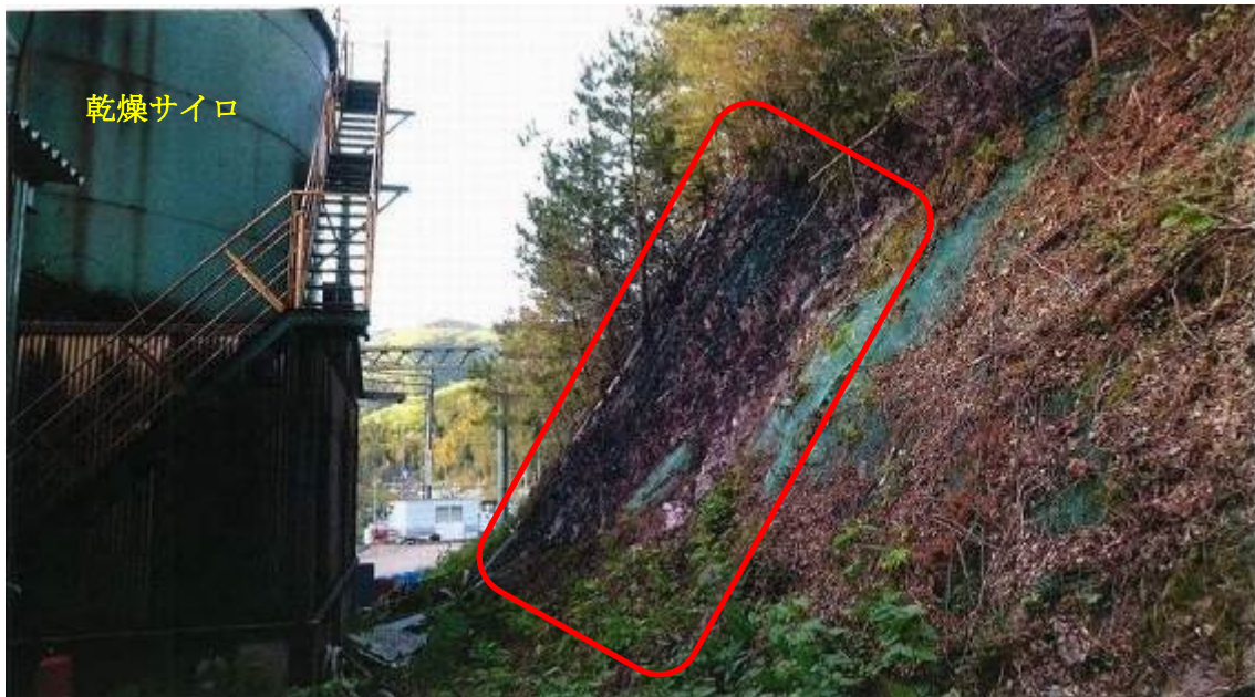
写真2 災害発生箇所の状況 (□が延焼箇所)
