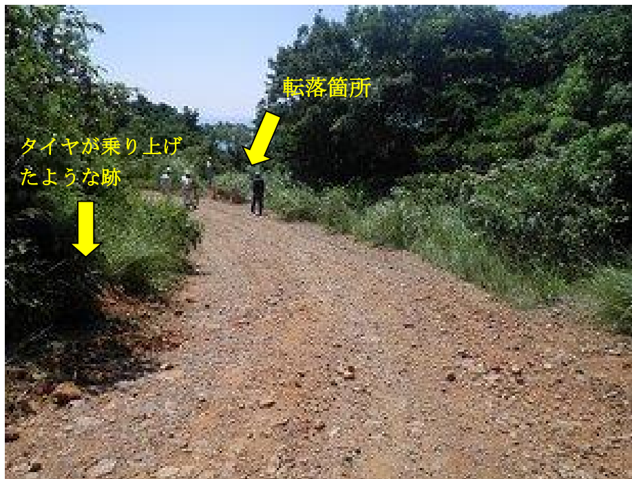
写真② 鉾山道路左カーブと転落箇所
