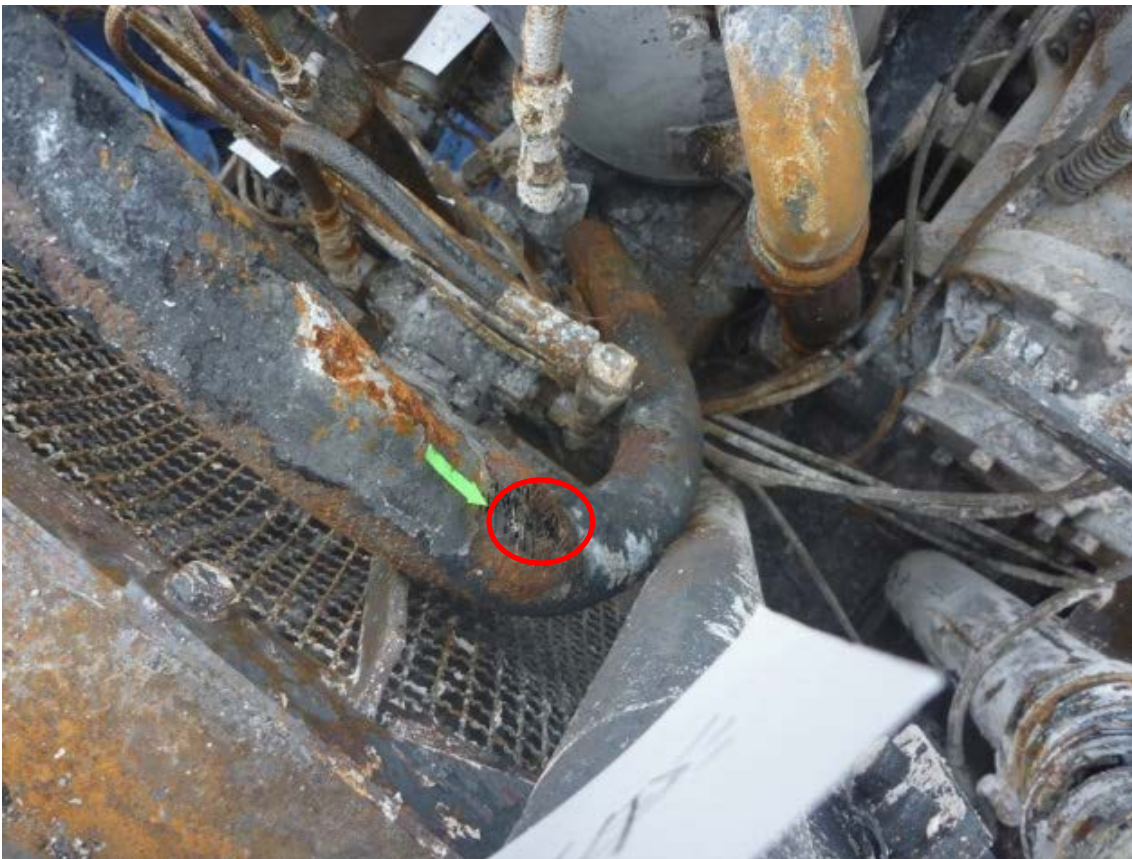
コンプレッサオイルホース（矢印の先の赤枠内に裂孔）
