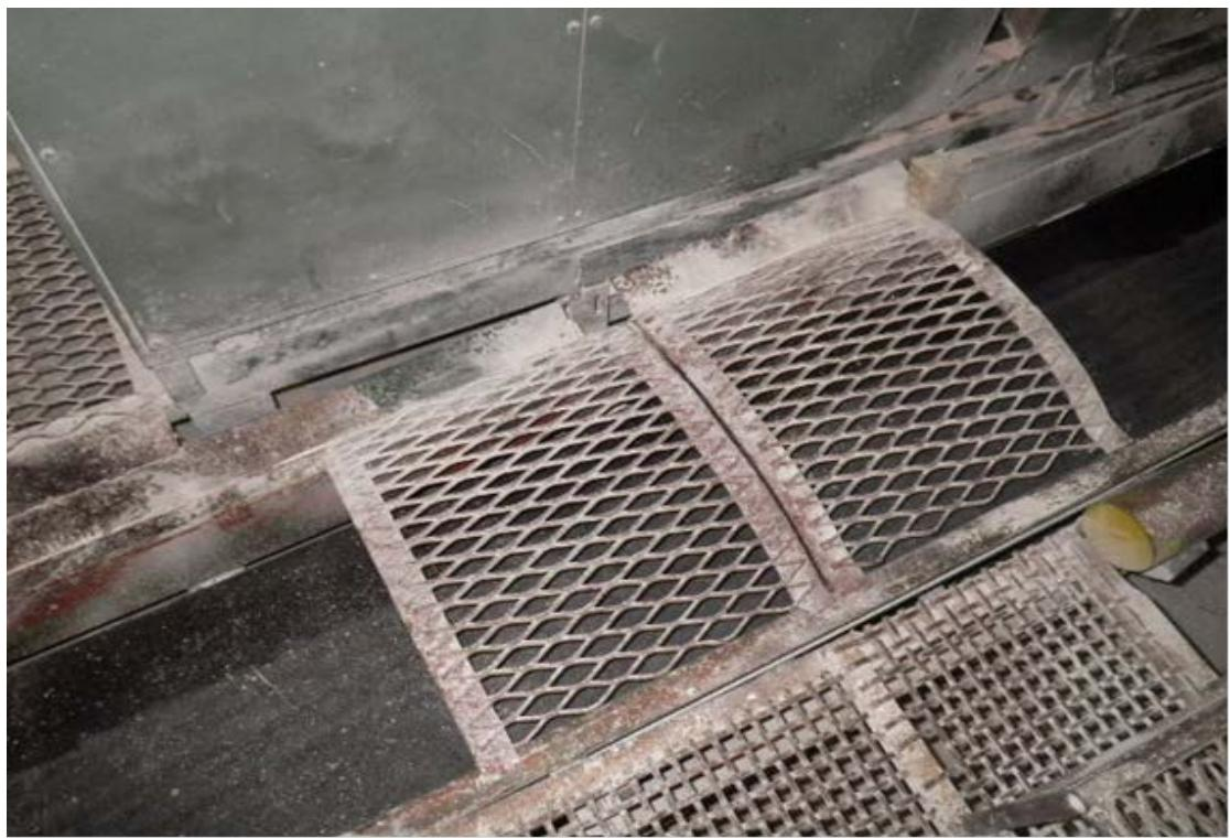
本来の作業用足場の設置状況（2枚を隣接して設置）
