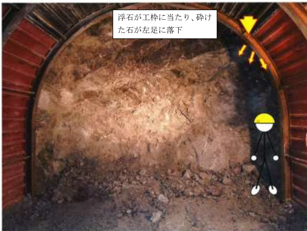
災害現場の状況
