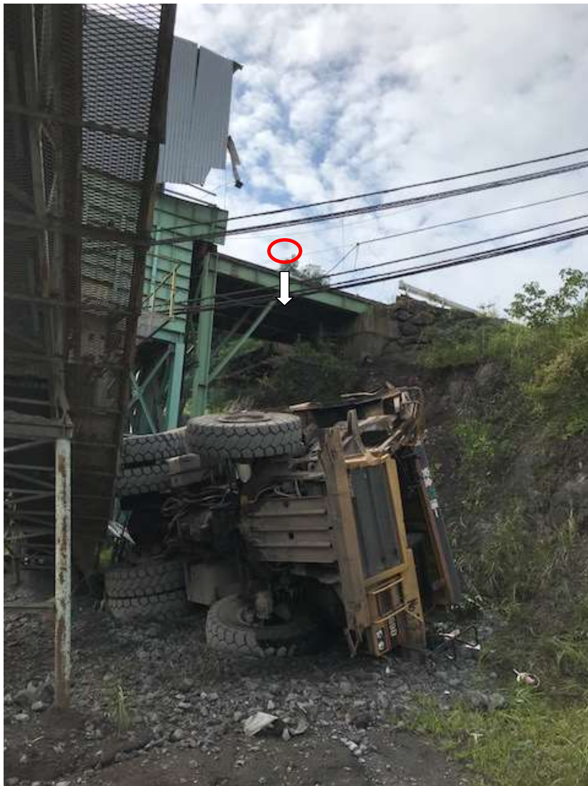
写真1：ダンプトラックの罹災状況（○印は転落推定箇所）
