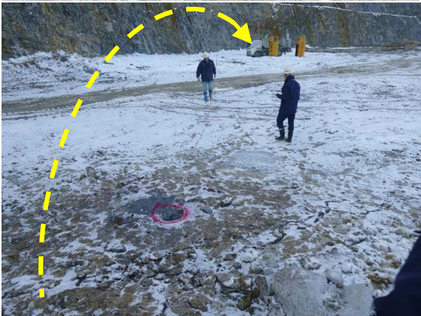
飛石発生切羽からポンプ車方向を望む
