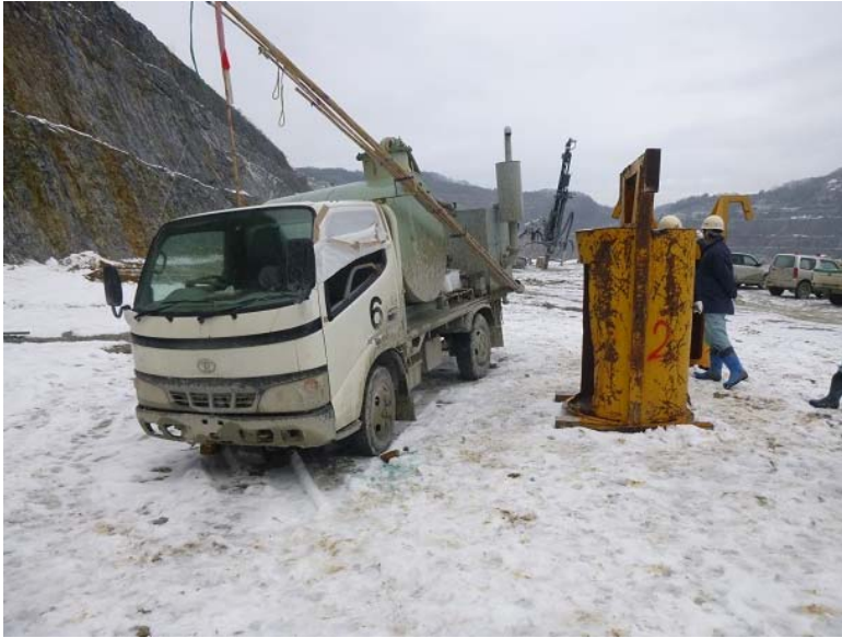
飛石で助手席サイドガラスが 破損したポンプ車とエンタイ (点火者防護用設備)
