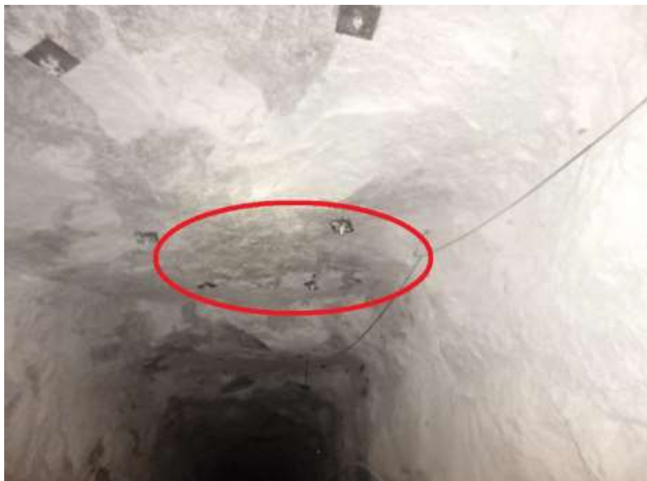
(天盤落盤箇所)
