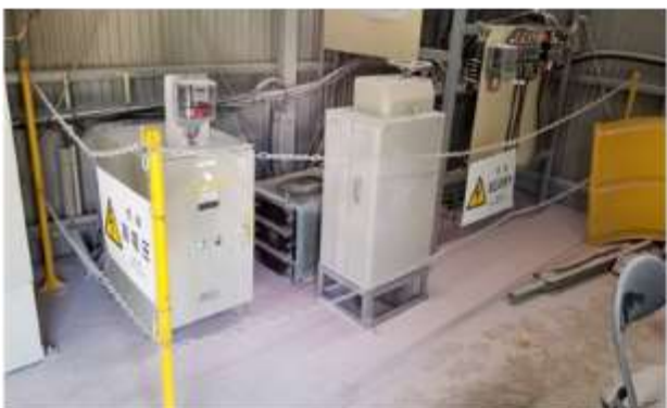
写真③(破砕制御室内 鎮火後)
