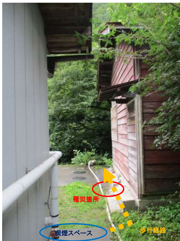
罹災箇所（鉦山事務所から罹災箇所に向けて撮影）
