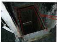
写真5 点検口から見た
