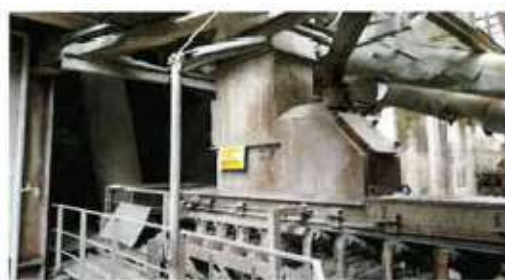
写真② 16-1 給鉱シュート警標設置状況－2
