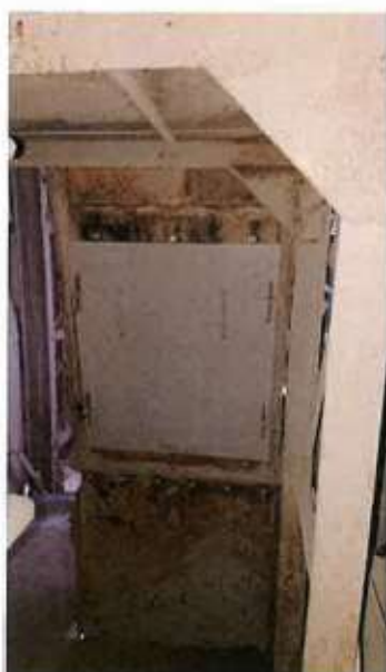
写真④ 点検口設置状況－1
