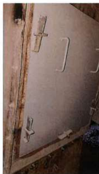
写真⑤ 点検口設置状況－1
