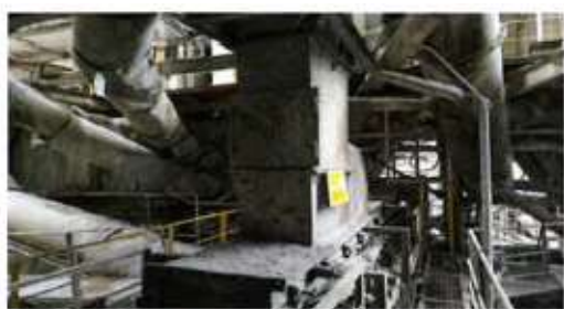
写真① 16-1 給鉱シュート警標設置状況－1
