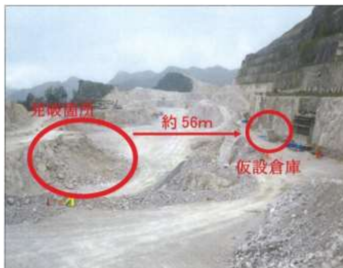
災害発生箇所（西側から撮影）
