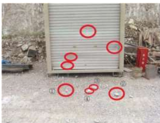
損傷箇所及び飛来した石灰石
