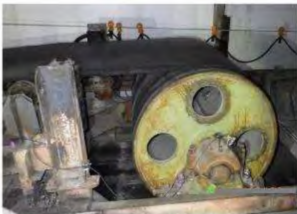
写真3 通常時のプーリー部
