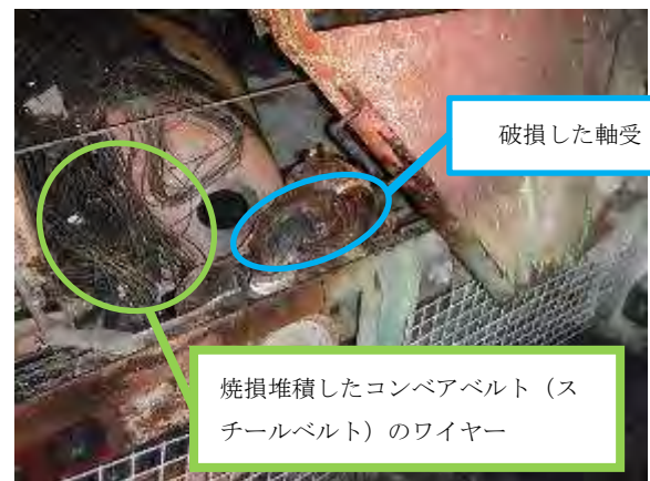
写真4 火災後のプーリー部
