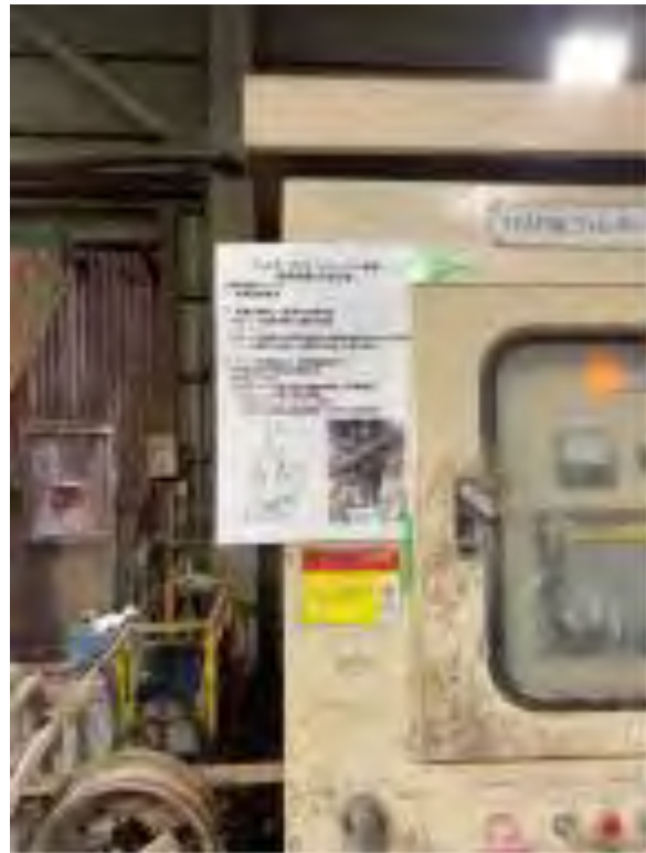
電源盤に応急ルールを掲示
