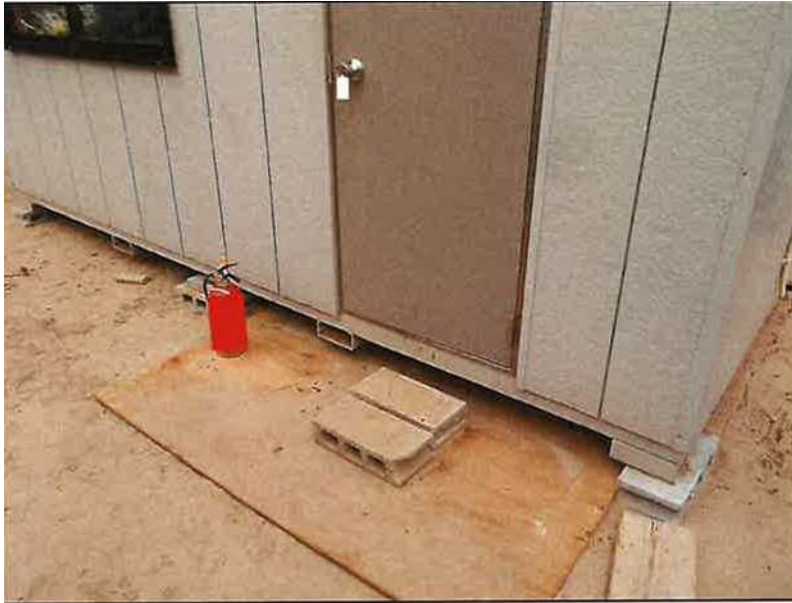
写真1 災害発生前にステップとして設置していたブロック
