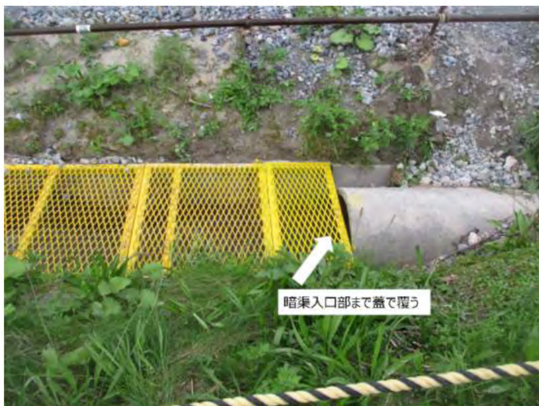
写真4 排水溝暗渠入口への流入防止設備の設置状況
