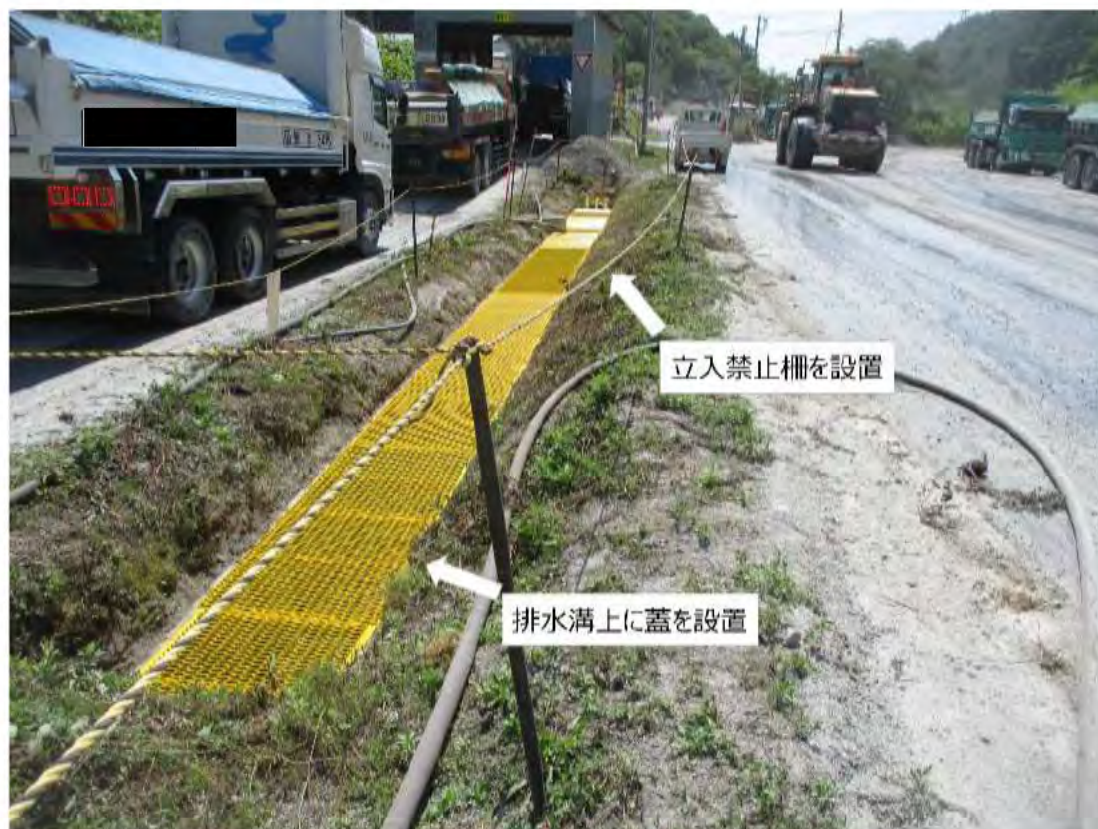
写真3 排水溝への転落防止の措置状況
