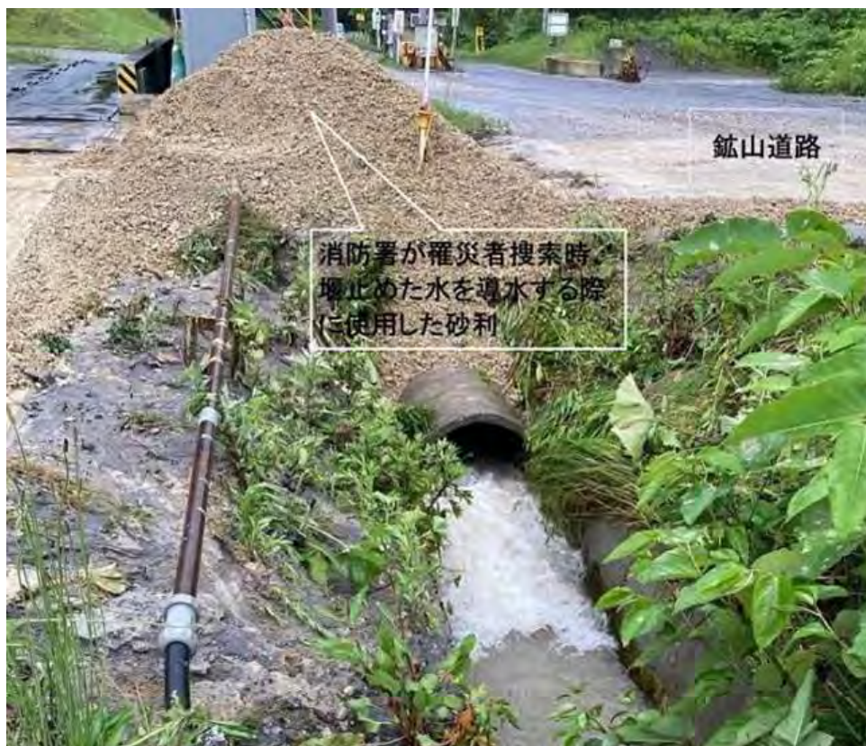
写真2 災害発生箇所の排水溝及び暗渠管入口（コンクリートヒューム管）の状況 （オーバーフロー解消後）
