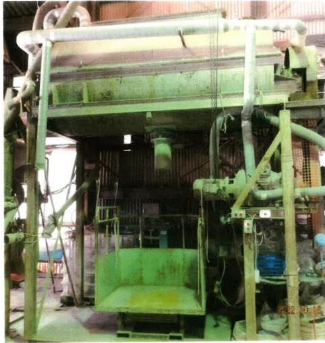
写真1 混錬機全景(正面から)
