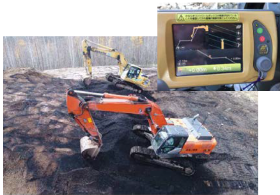
（ICT建機による施工）
