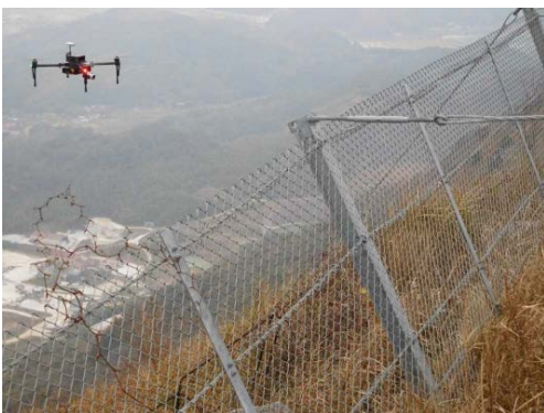
（斜面地の落石防止柵点検）
