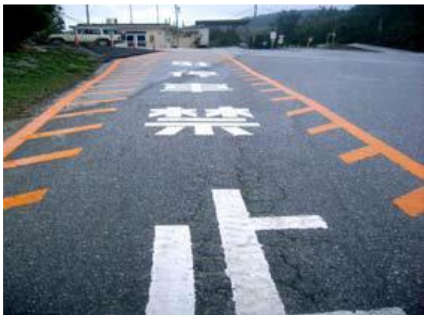
傾斜地を駐停車禁止帯とした
