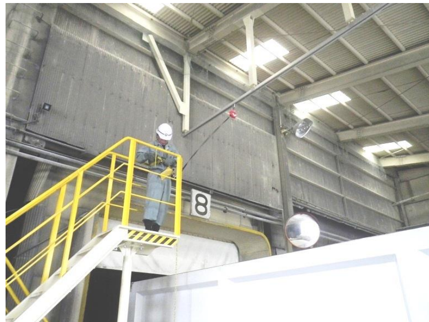
墜落制止用器具をレールに取付け転落防止
