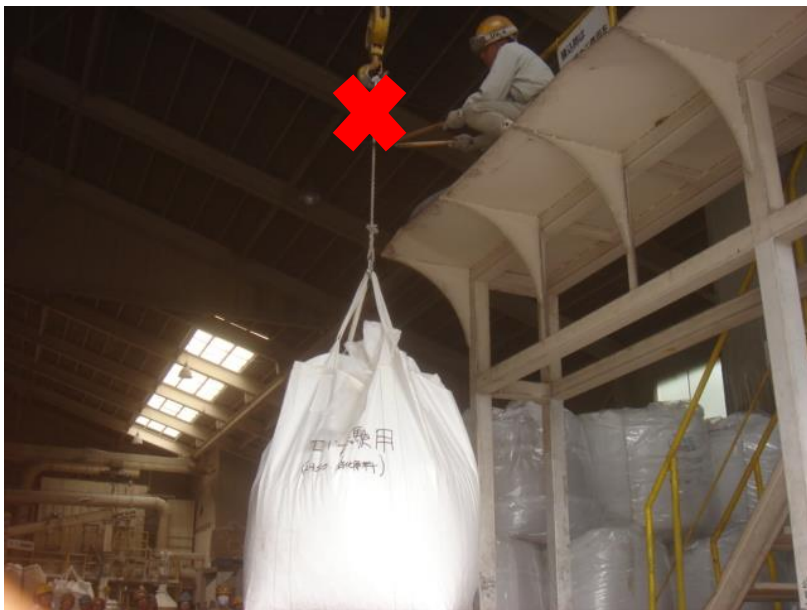
吊りロープを切断する
