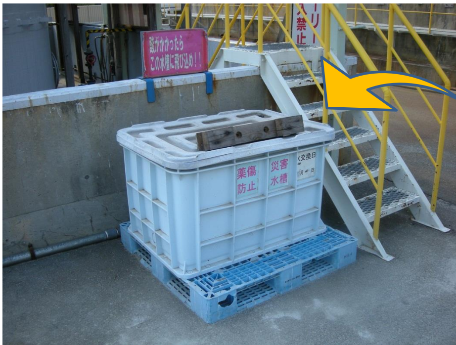
薬傷災害防止用の水槽
