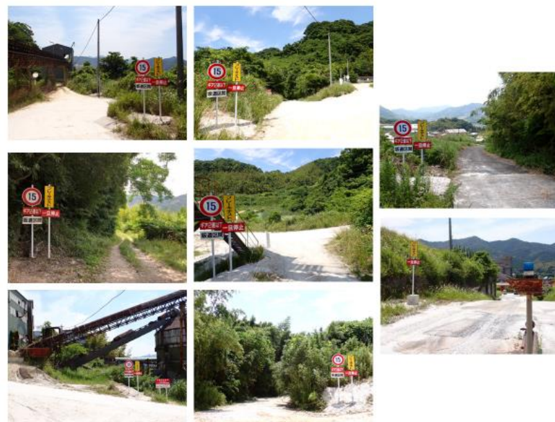
「ブレーキテスト」「一時停止」等の標識設置
