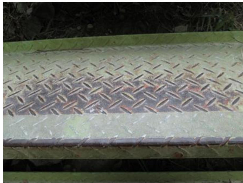
階段の滑り止めテープ(拡大写真)
