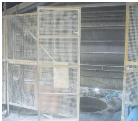
設備の周囲に柵を設置
