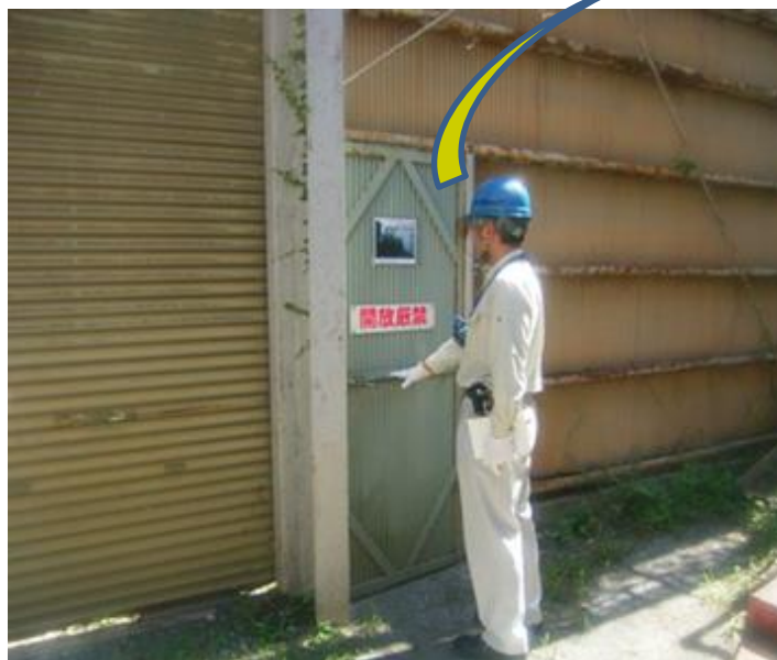
出入口の扉（外開きを内開きに改修）
