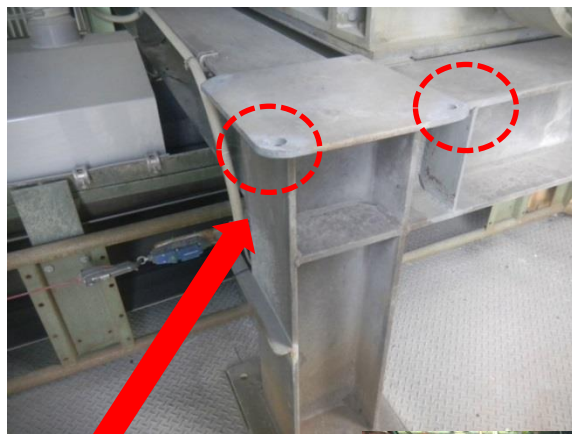
鉄骨の角部の面取り
