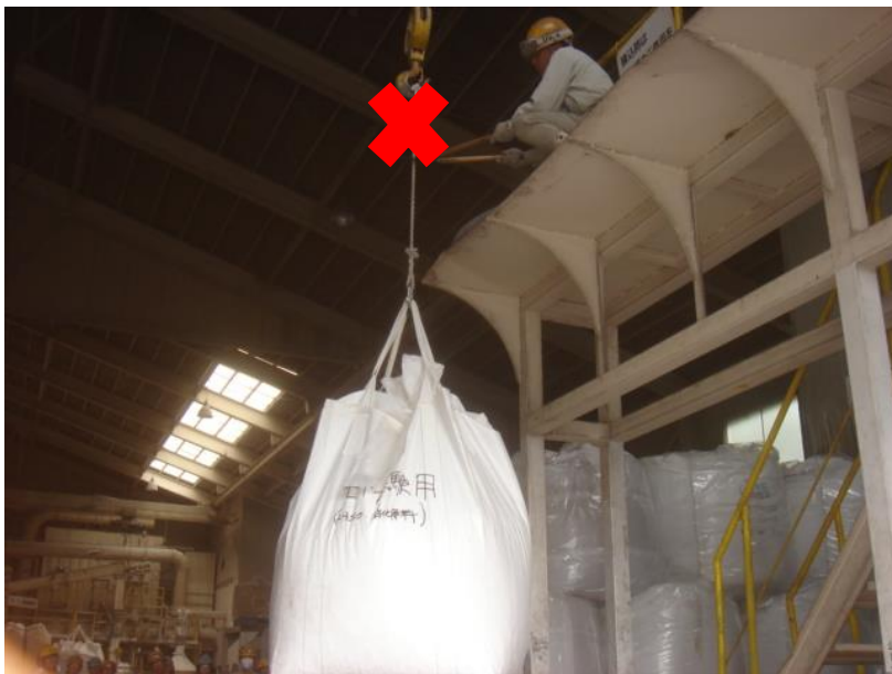
吊りロープを切断する
