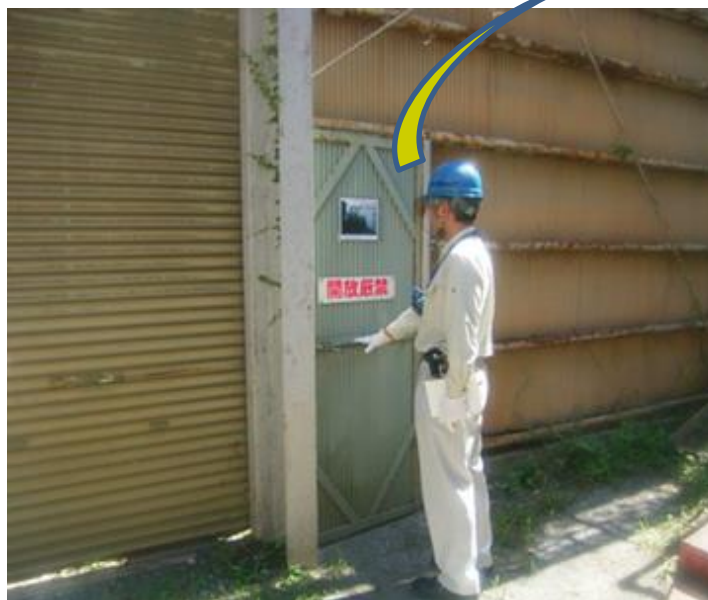
出入口の扉(外開きを内開きに改修)
