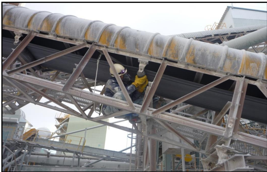
改善前：高所ベルトコンベアローラー交換作業
