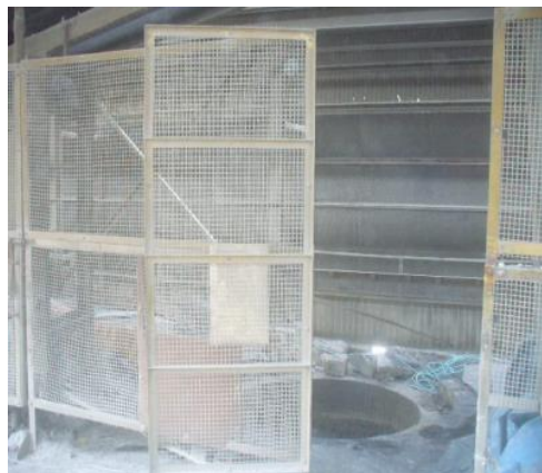
設備の周囲に柵を設置
