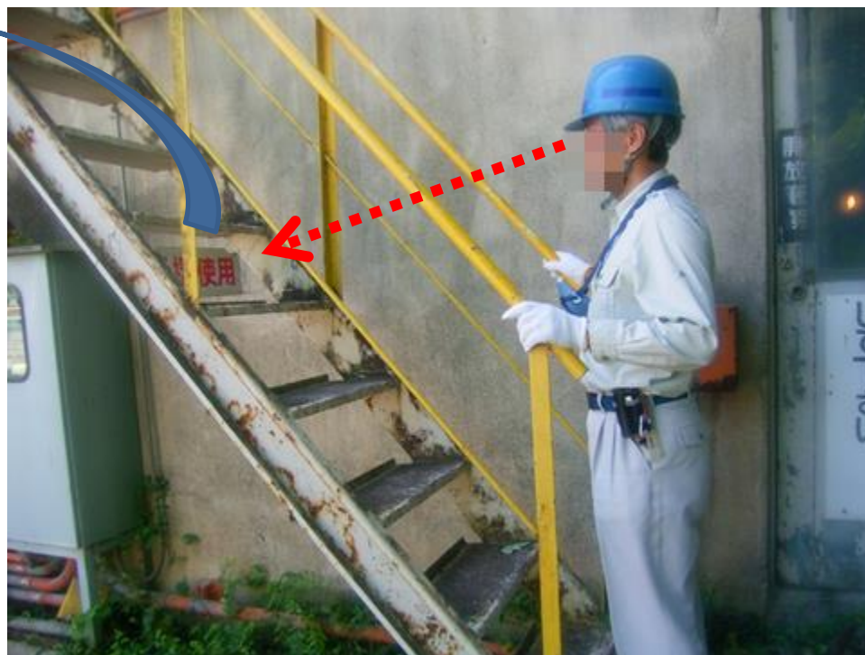
作業者の目線と同じ高さに注意喚起の表示を掲げている
