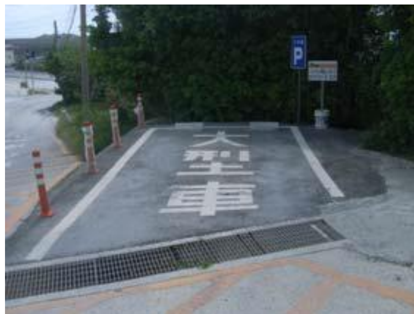
大型車用の駐車場を造成
