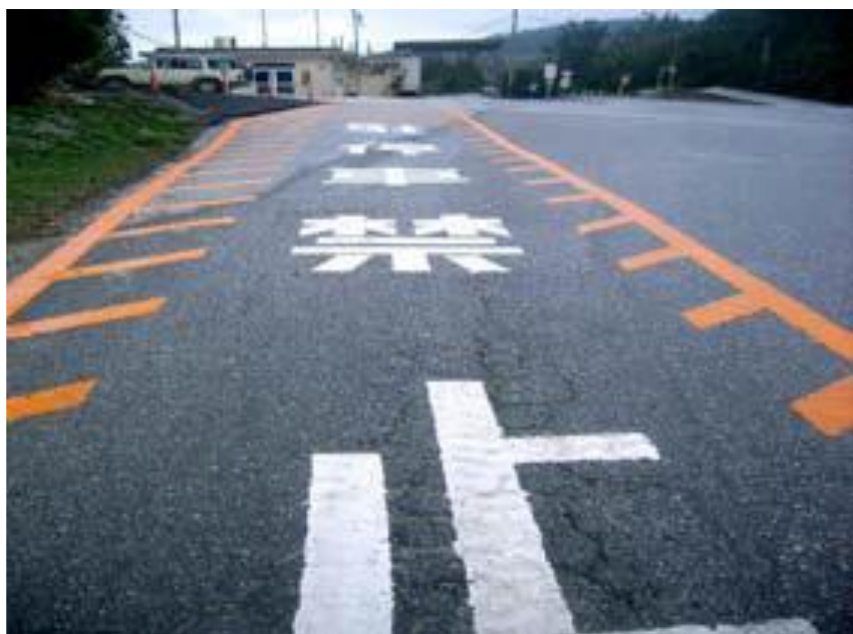
傾斜地を駐停車禁止帯とした
