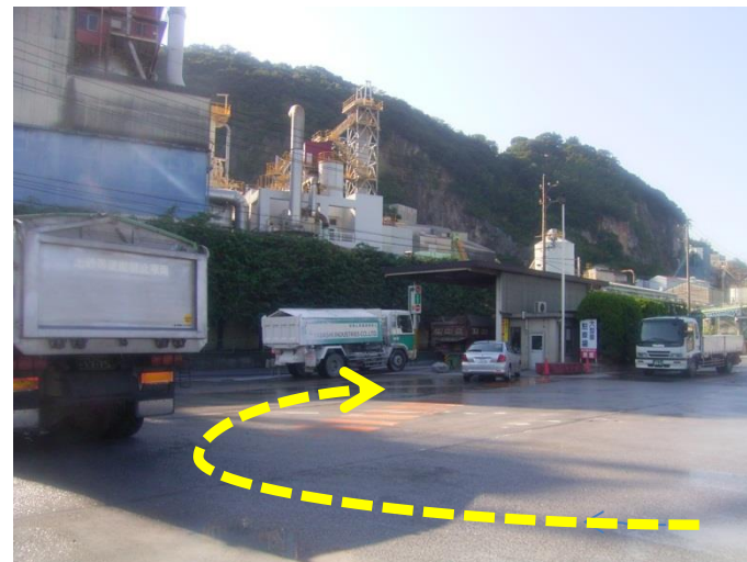
検量待ちのトラックが交錯しないように、 検量所の周囲を一方通行にしている
