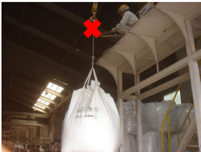
吊りロープを切断する
