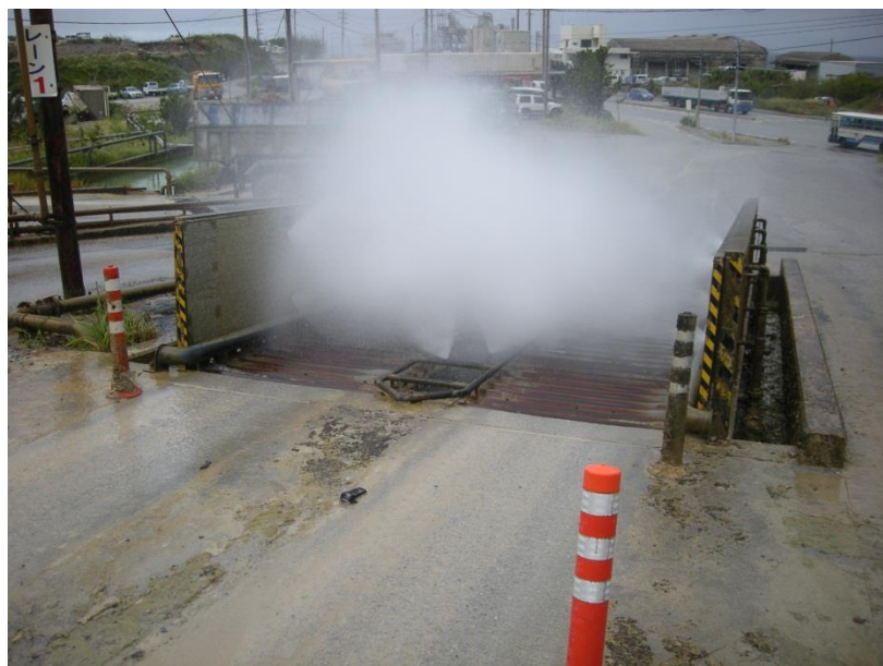
左右側面と中央部から高圧水を噴射
