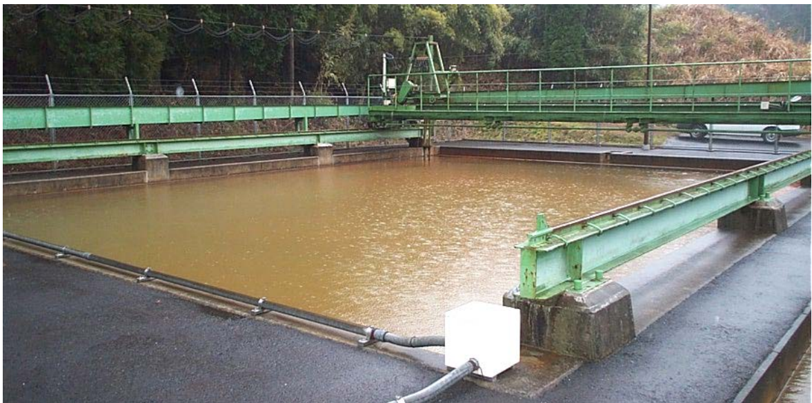
写真 3 - 4 : 横流れ式沈殿池
