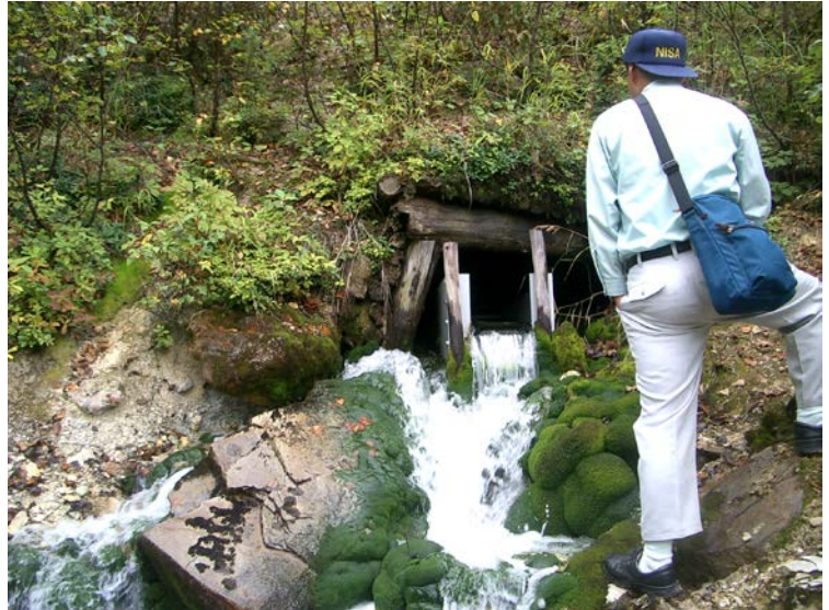
写真 1 - 1 : 旧坑坑口からの坑廃水流出現場
