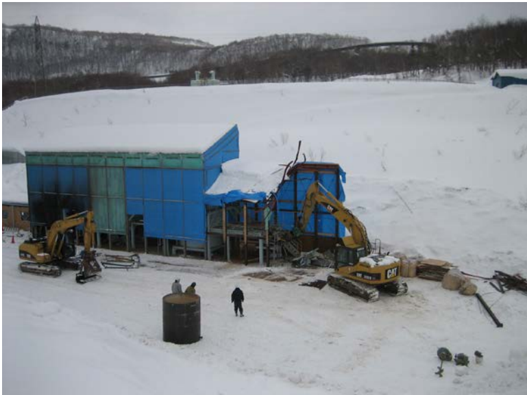
脱水工程の解体・撤去工事
