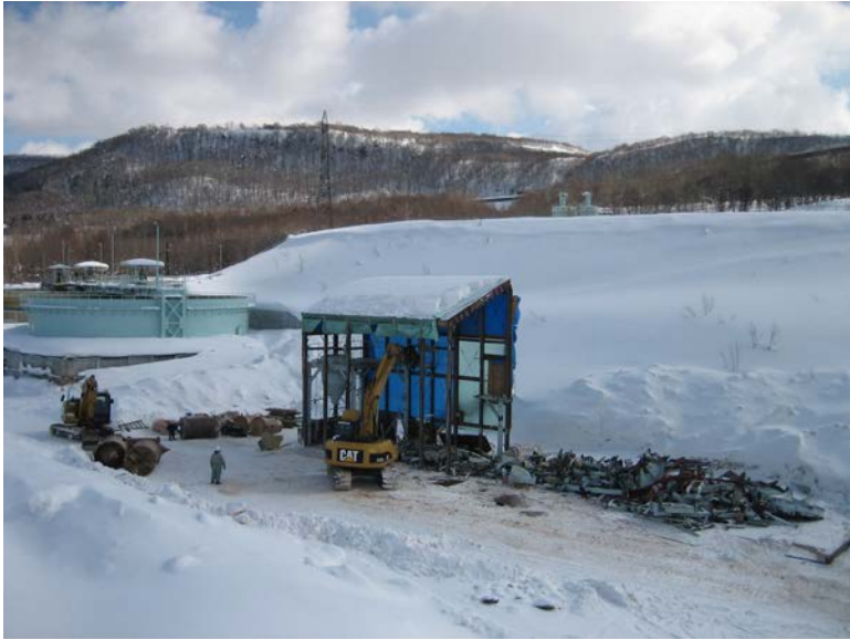
酸化工程の解体・撤去工事
