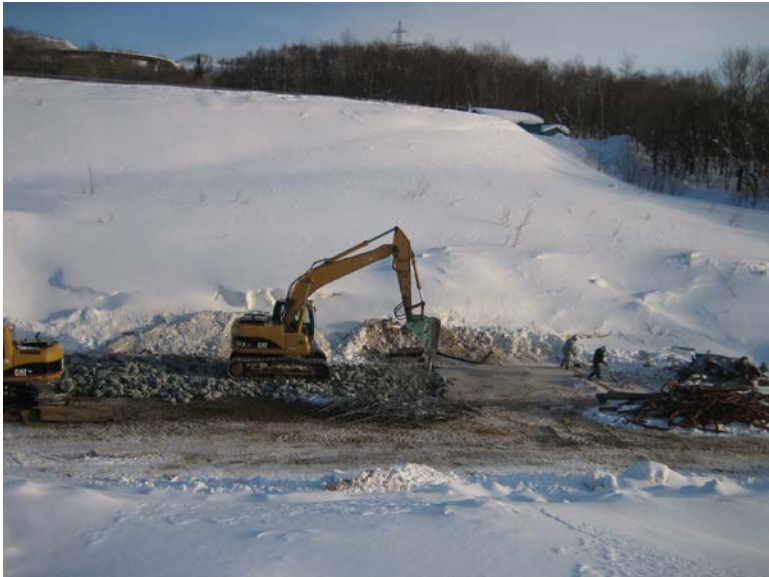
土間基礎の解体・撤去工事
