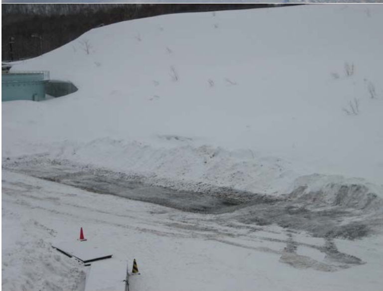
解体・撤去工事完了
