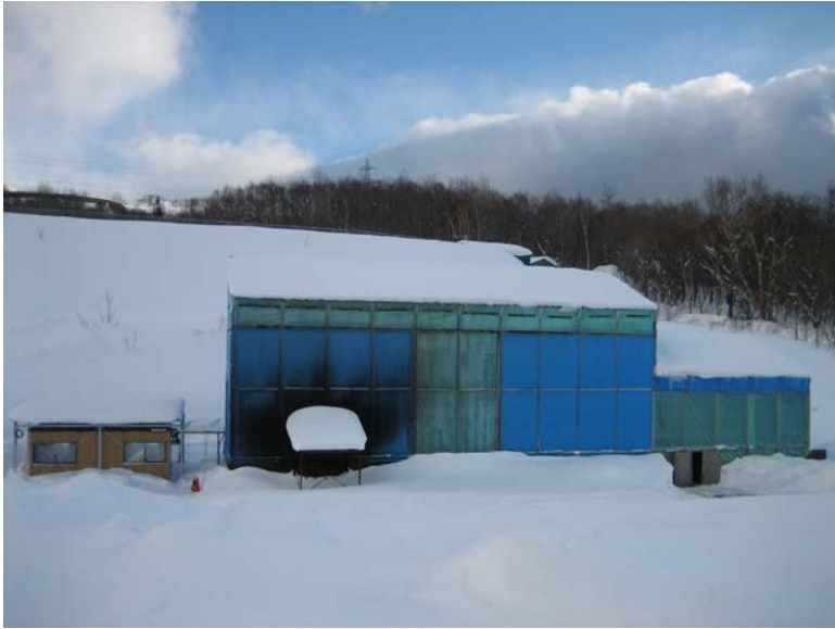
解体・撤去工事前
