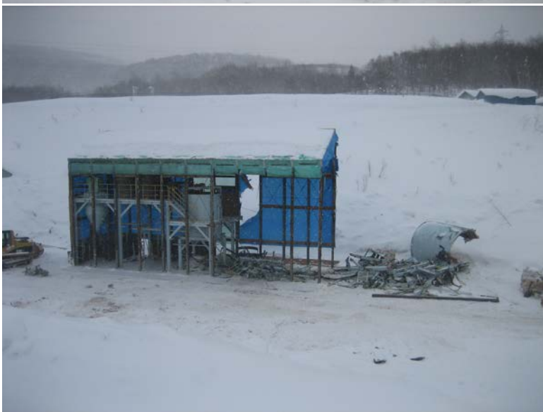
中和工程の解体・撤去工事
