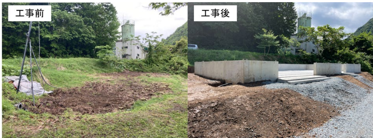
図 2.8-4 土間基礎工事前後の現地状況
