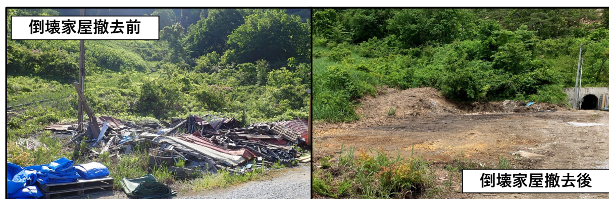
図 2.5-23 倒壊家屋撤去状況
