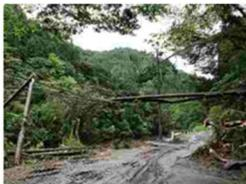
倒木による電線断線→停電
