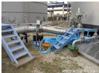
タンク付近が液状化、タンクが沈下
