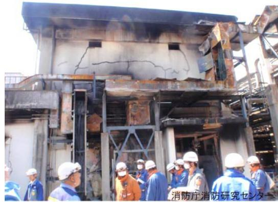
製造装置の制御室の焼損
