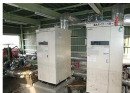
ボイラー室：扉より浸水し、制御盤故障
