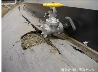
大規模タンクの沈下(バルブの下部が基礎に接触)
