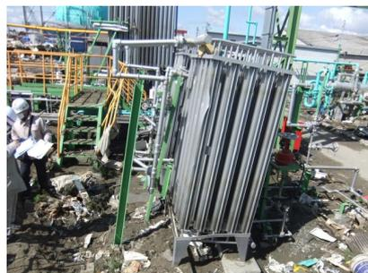
タンク加圧蒸発器(中圧)のフィン変形等
