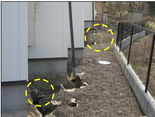
地震により造成盛土が崩壊し、立入禁止となった家屋における内管 (PE 管) (急傾斜地のため地盤変状が大きかったものの、PE 管は健全性を保持)
