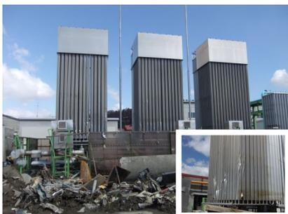
LNG 気化器(中圧)のフィン一部が損傷
