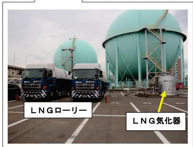
一般ガス事業における仮設配管による仮復旧事例
