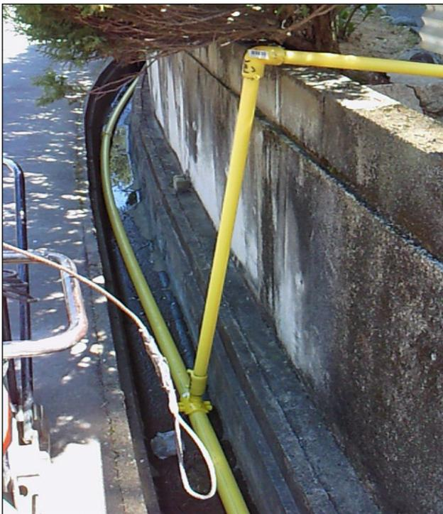
PE管（本支管・供給管）の仮設
