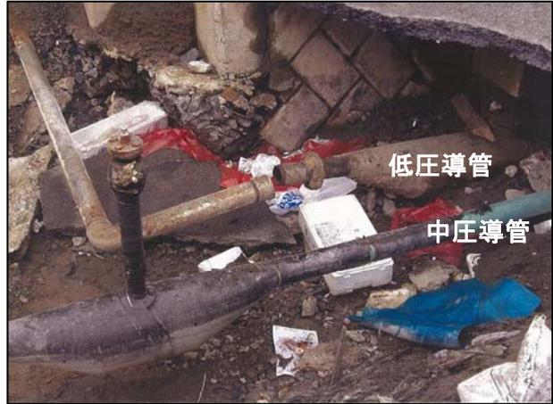
津波による路盤洗掘に伴い露出した中圧導管
