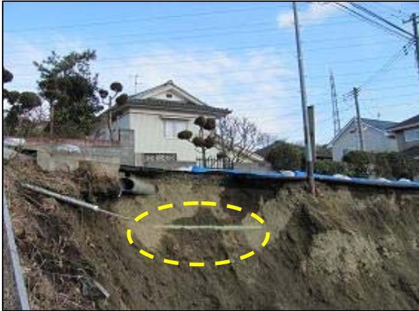
地震による土砂崩壊に伴い露出した中圧導管
