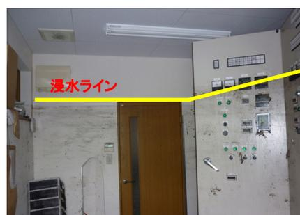
制御室：扉より浸水し、制御盤故障
