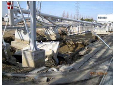
配管・架構類(杭基礎なし)は津波により損傷
