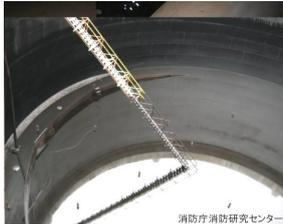
浮き屋根上に溢流(3日後に浮き屋根沈没)
