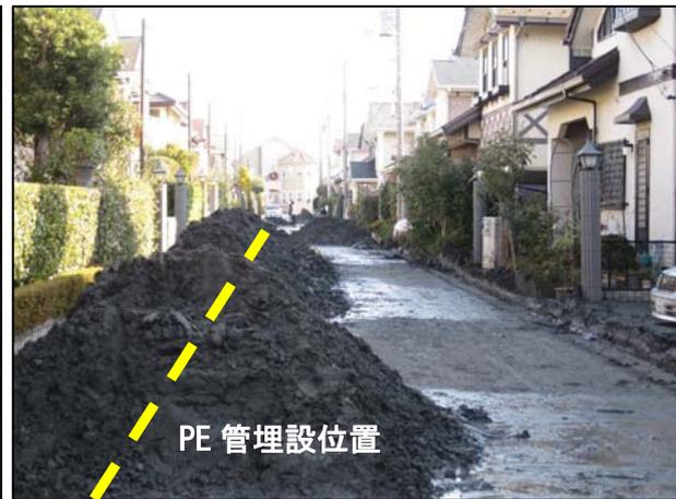
液状化地区における低圧導管 (PE 管)
