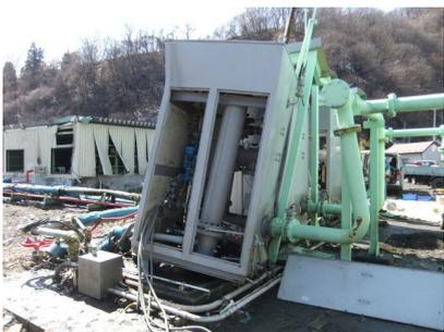
LPG 気化器(中圧)は漂流物の衝突により損傷
