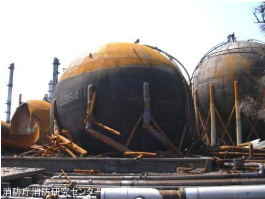
ガスタンクの支柱が座屈し配管を損傷
