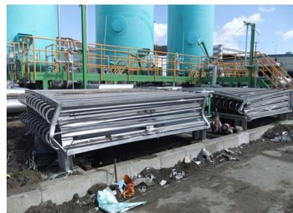
LNG ローリー加圧蒸発器(中圧)のフィン損傷、チューブ破断
