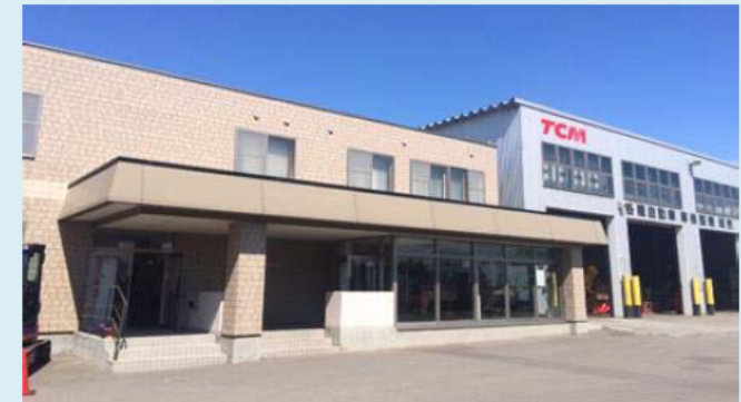
札幌本社 正面全景
