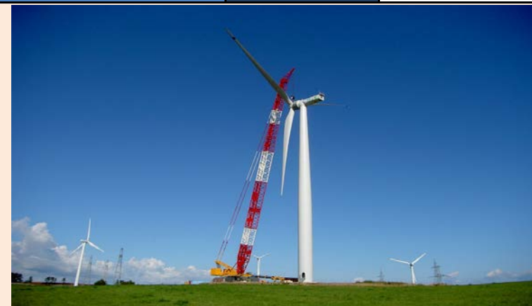
風車建設の様子。
