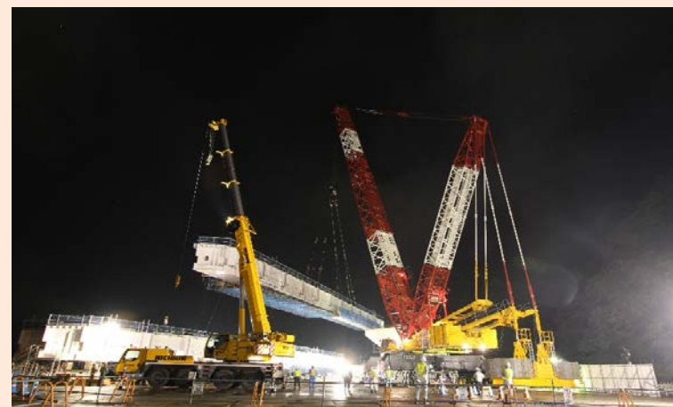
橋梁架設の様子。
