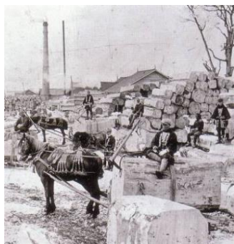
大正時代の製材現場
