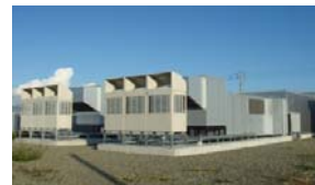
(環境配慮型クラウドデータセンター)
