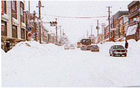
流雪溝設置前 流雪溝設置前市内風景
