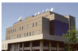
(自治体ネットワークセンター)
