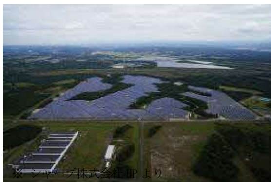
< 大規模太陽光発電所 >
