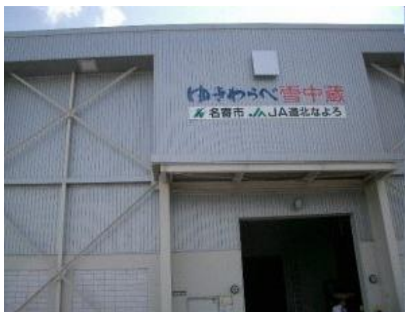
【雪室型もち米低温貯蔵施設】
