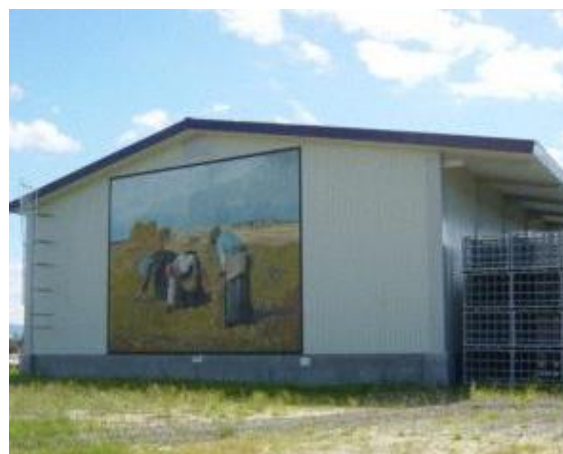
【農産物出荷調整利雪施設】
