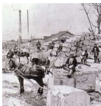
大正時代の製材現場
