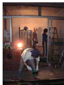
空き店舗の改装も 自らの手で行う
