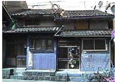
同地区に存在する空き長屋
