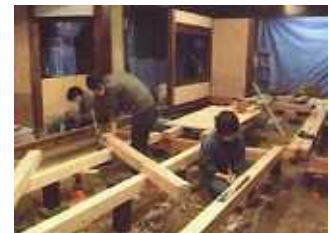
学生も参加した耐震改修工事の様子
