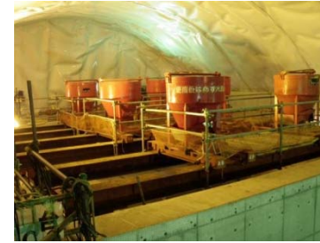
充填材試験状況
