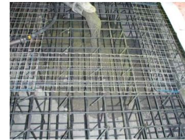
上部コンクリートピット試験状況
