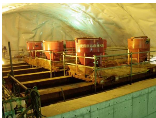
バケット設置状況
