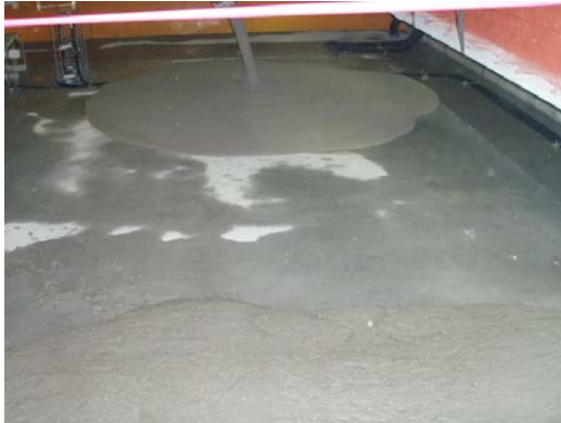
モルタル打込み打設状況
