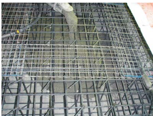
コンクリート打込み状況
