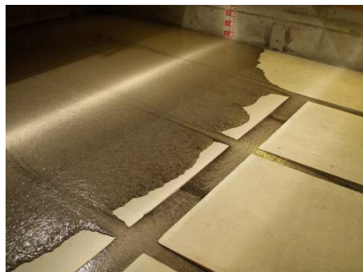
上部充填材充填状況
