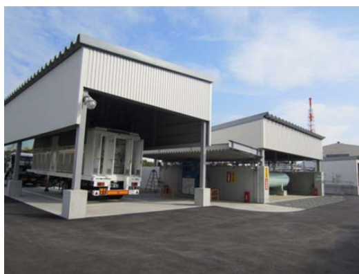
図 3 - 1 2 既設水素出荷実証設備
