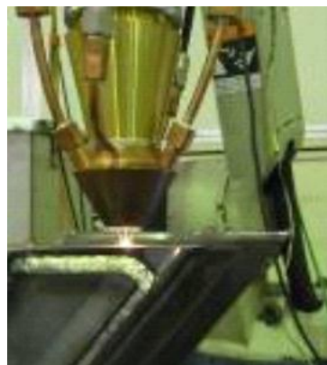
図 2 8 冷却通路の溶接状況(レーザー工法)
