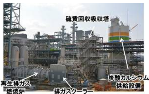
図 2-9 硫黄回収設備建設状況
