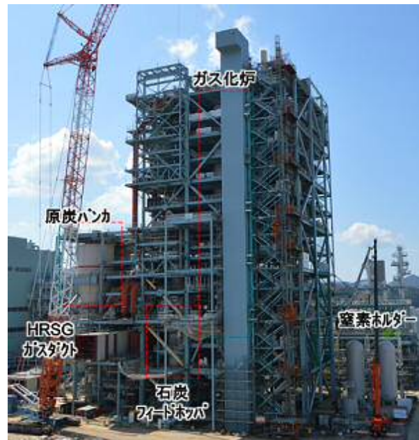
図 2-5 石炭前処理設備建設状況
