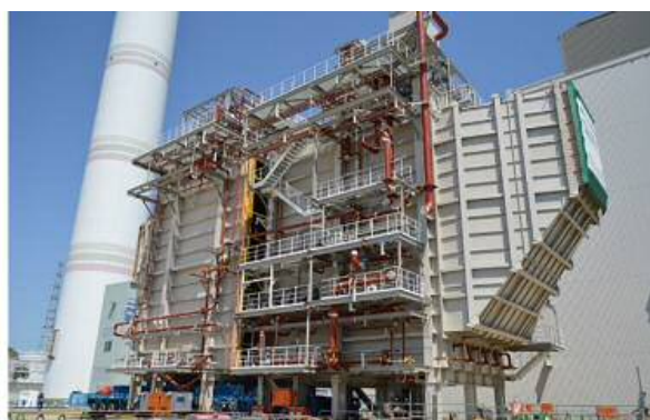
図 2-11 排熱回収ボイラ建設状況
