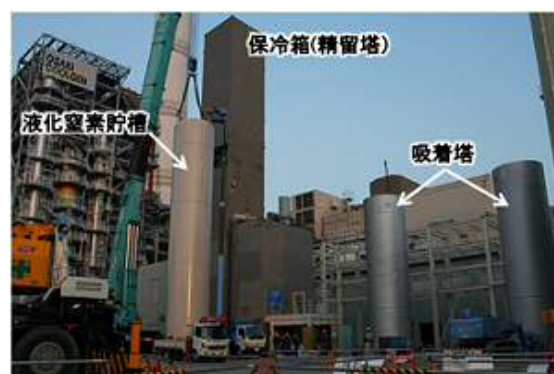
図 2-15 空気分離設備建設状況
