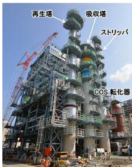
図 2-8 ガス精製設備建設状況
