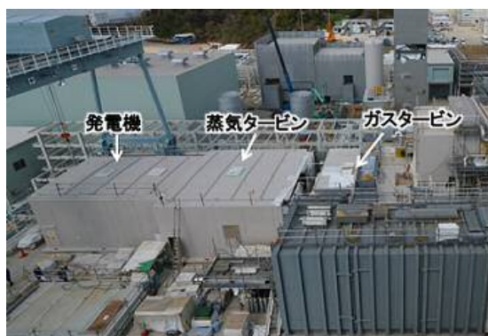
図 2-10 複合発電設備建設状況
