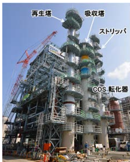
図 3-8 ガス精製設備建設状況
