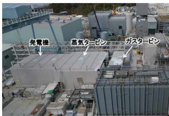
図 3-10 複合発電設備建設状況
