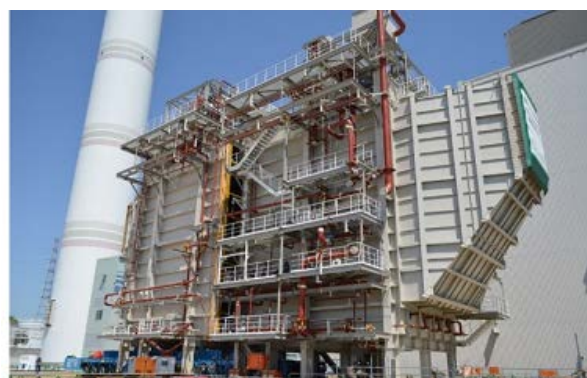
図 3-11 排熱回収ボイラ建設状況
