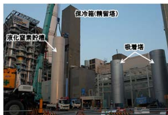
図 3-15 空気分離設備建設状況
