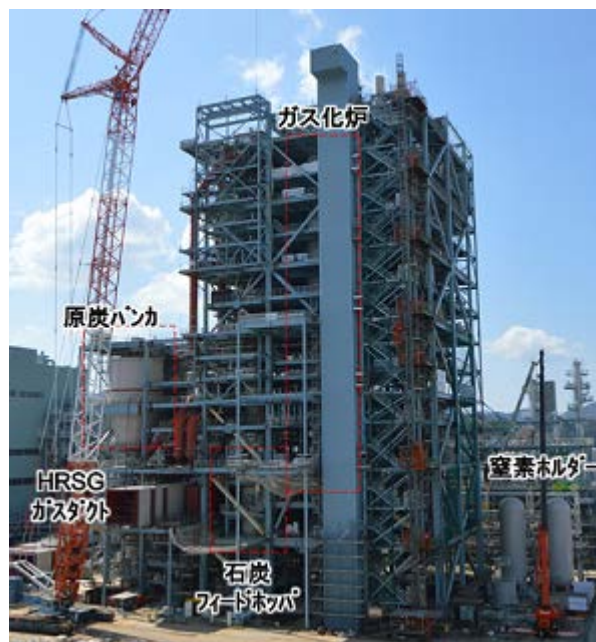
図 3-5 石炭前処理設備建設状況
