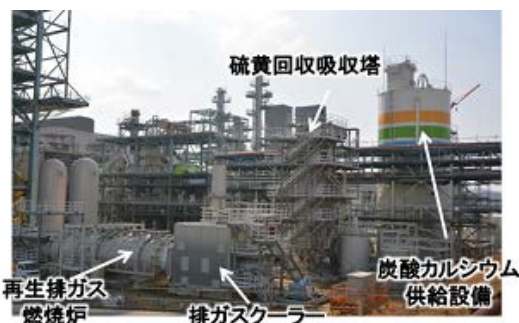
図 3-9 硫黄回収設備建設状況
