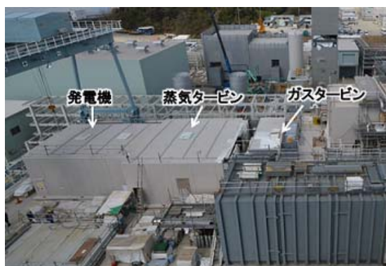
図 3-10 複合発電設備建設状況
