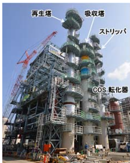
図 3-8 ガス精製設備建設状況
