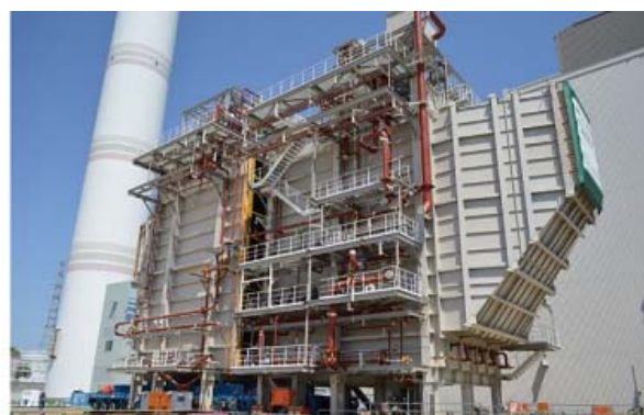
図 3-11 排熱回収ボイラ建設状況
