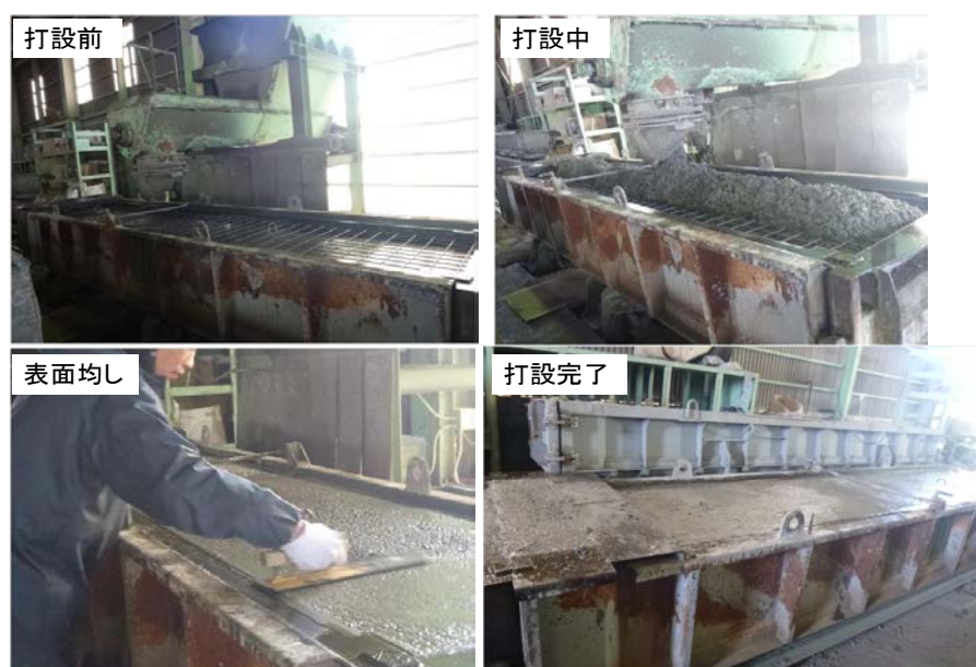
ロングベンチフリーム打設状況
