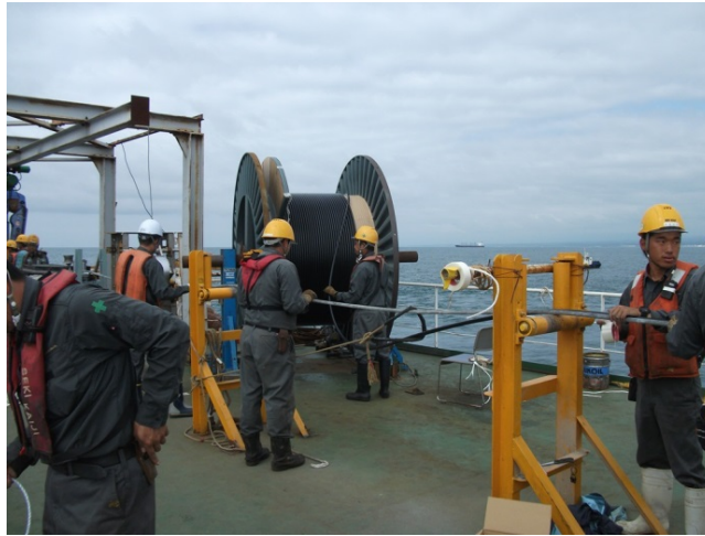
図 3-50 海底ケーブルの敷設
