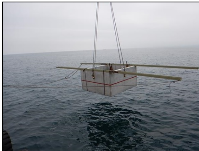
図 3-51 海底設置容器の敷設
