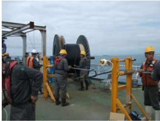
図 3-51 海底ケーブルの敷設
