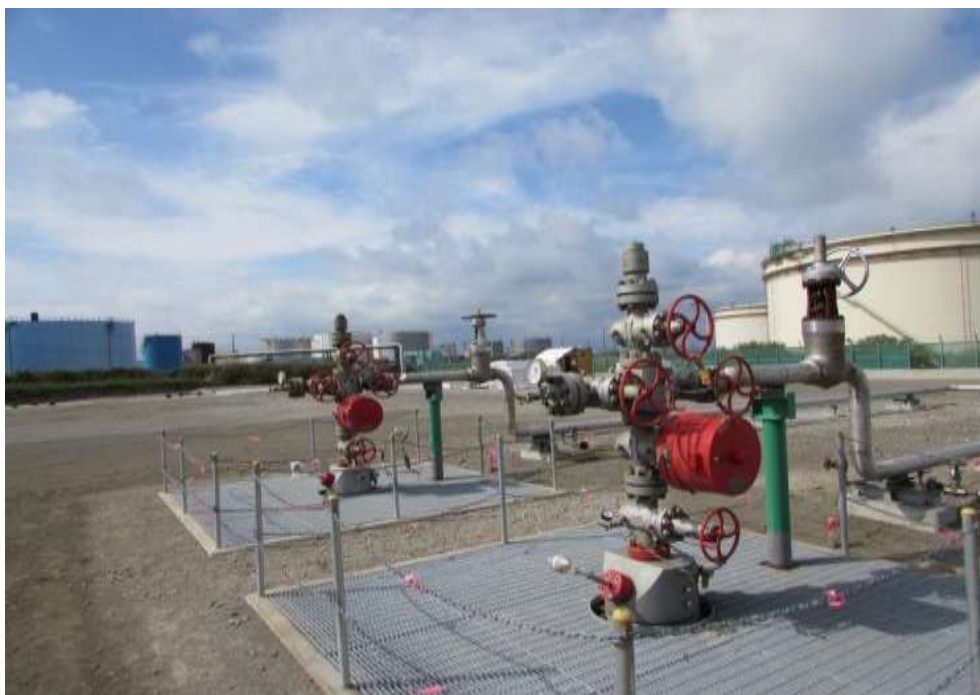
図 3-2 圧入井 2 坑の坑口装置
