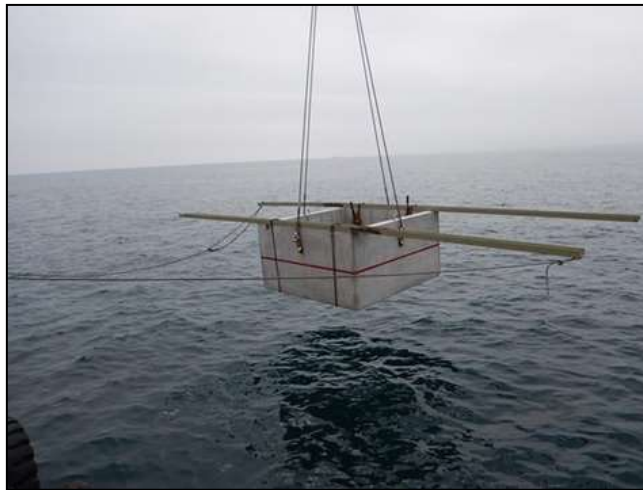
図 3-52 海底設置容器の敷設
